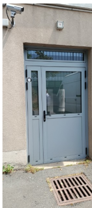
Accès au local de stockage
